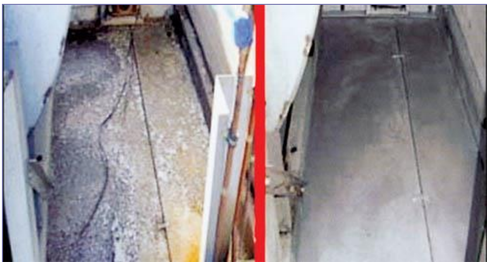
Рисунок 7. Воздуховод до и после обработки
